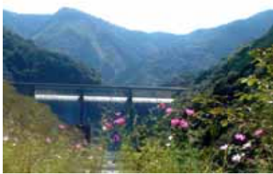
「南紀用水・島之瀬ダム」
